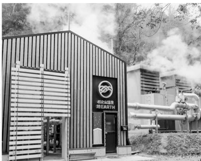
来年の本格稼働に向けて試運転を続けている松之山温泉の発電所
